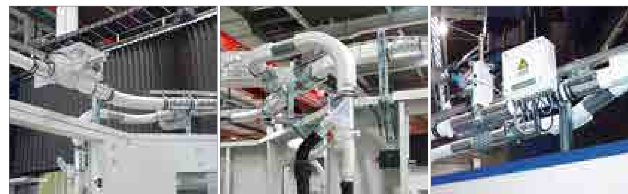
● Buisleidingsysteem met elektropneumatische schuif en elektrische besturingseenheden
